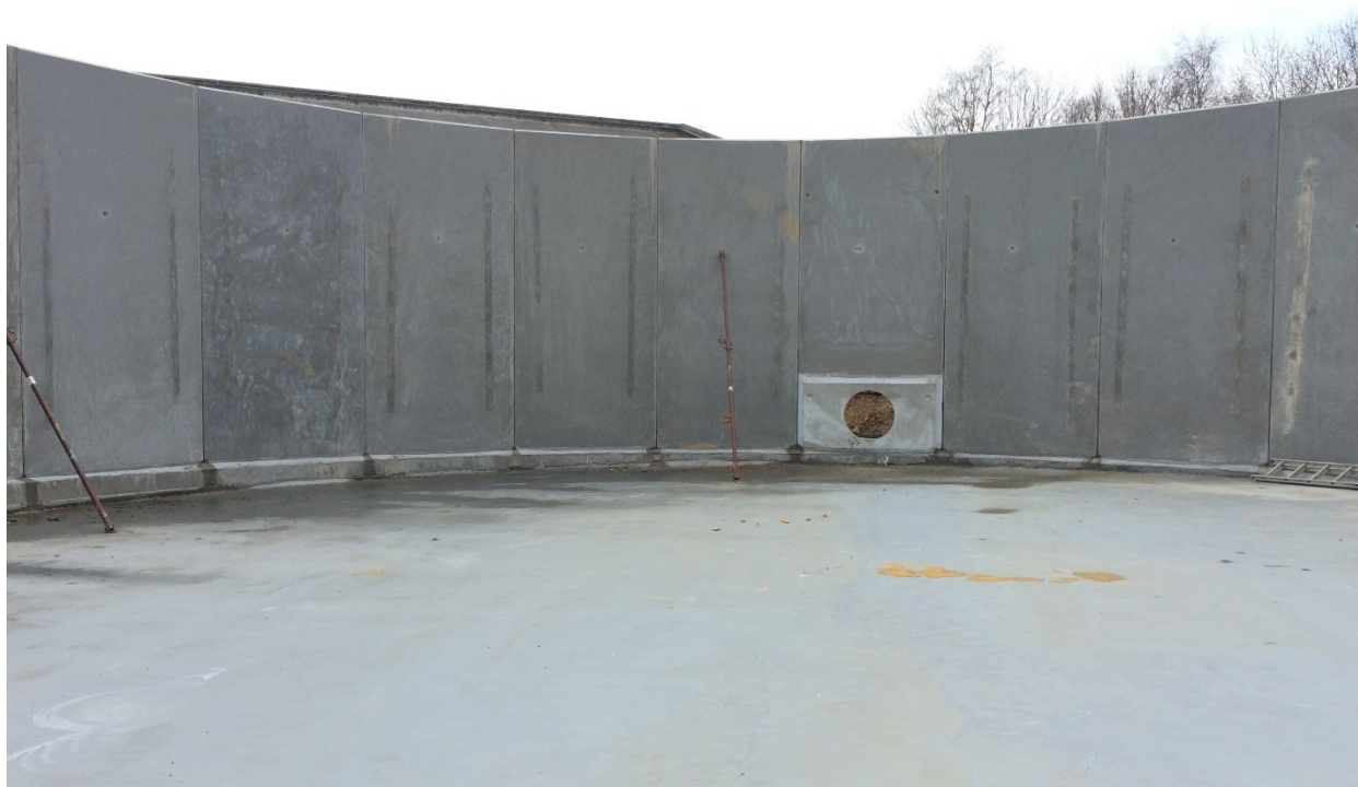
Indersiden af det nye bassin på Lynge Renseanlæg
