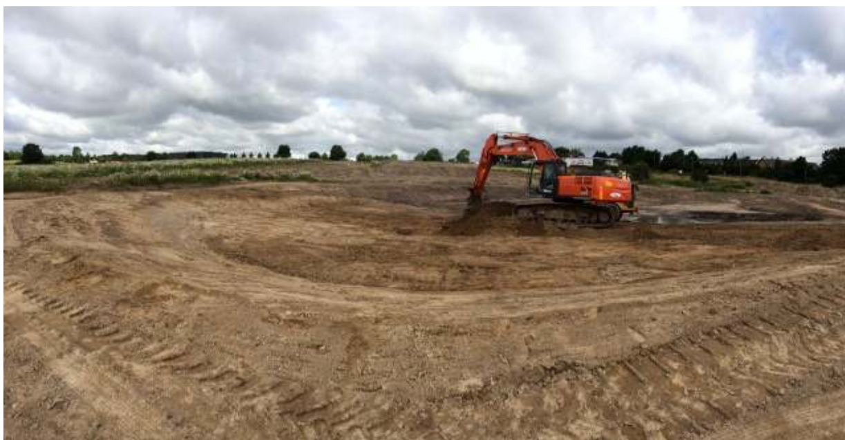
Etablering af nyt bassin ved Kongevejen i Blovstrød
