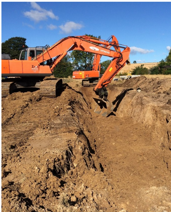
Etablering af ny regnvandsledning syd for Blovstrød
