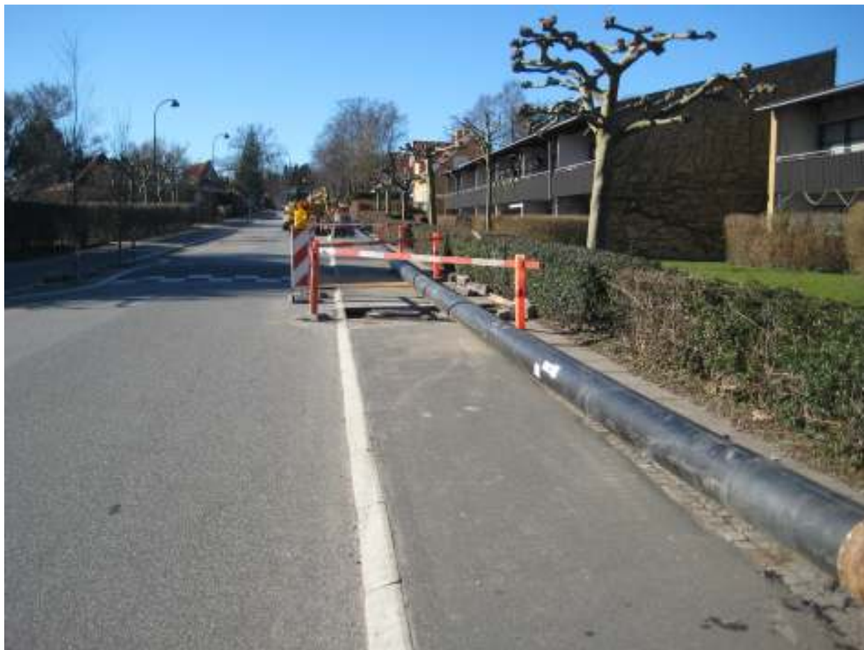
Renovering af kloakledninger i Rudersdalsvej ved cracking
