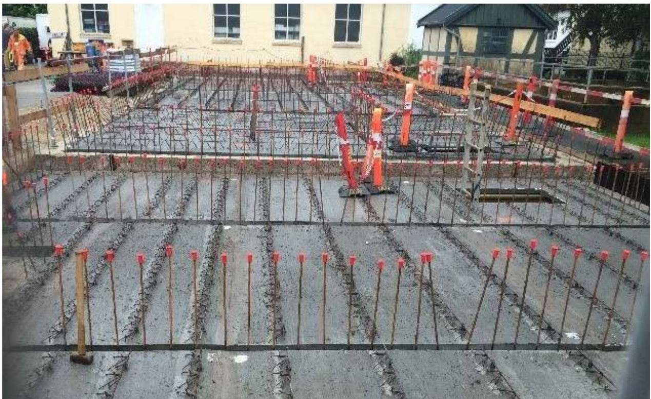
Filigrandæk på rentvandstanke, Holte Vandværk
