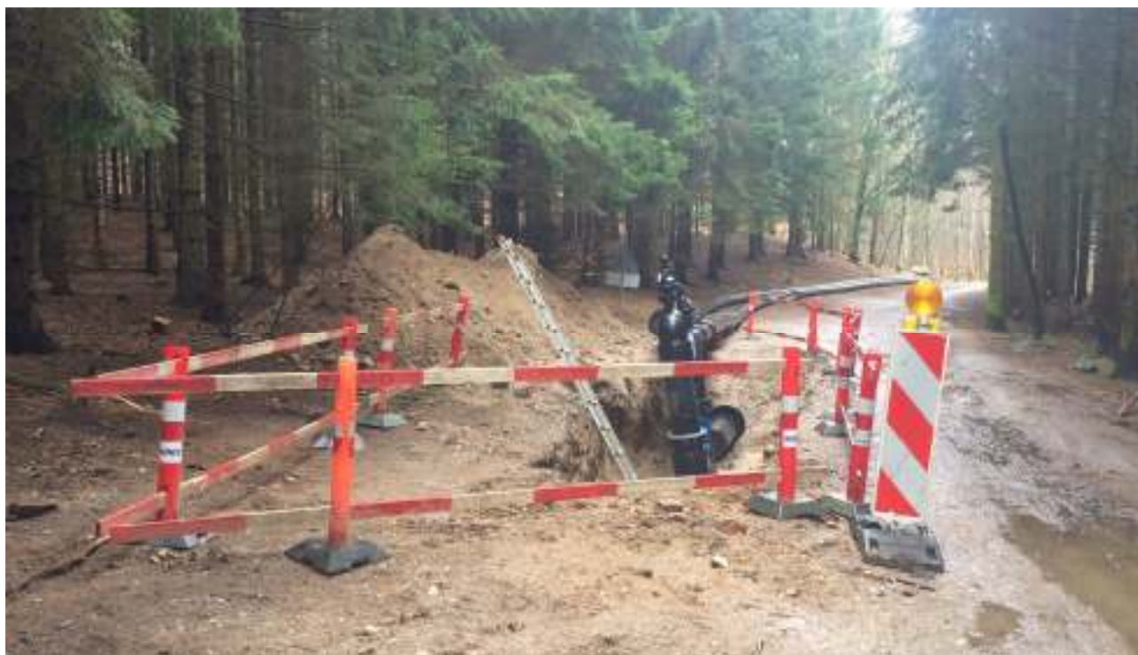
Renovering af kloakledninger i Geelsskov
